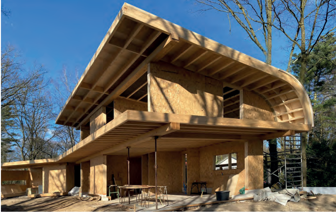
Een eerder met de SIP-panelen gerealiseerd huis in Nederland. Er zijn veel vormen mogelijk met deze constructieve panelen.
